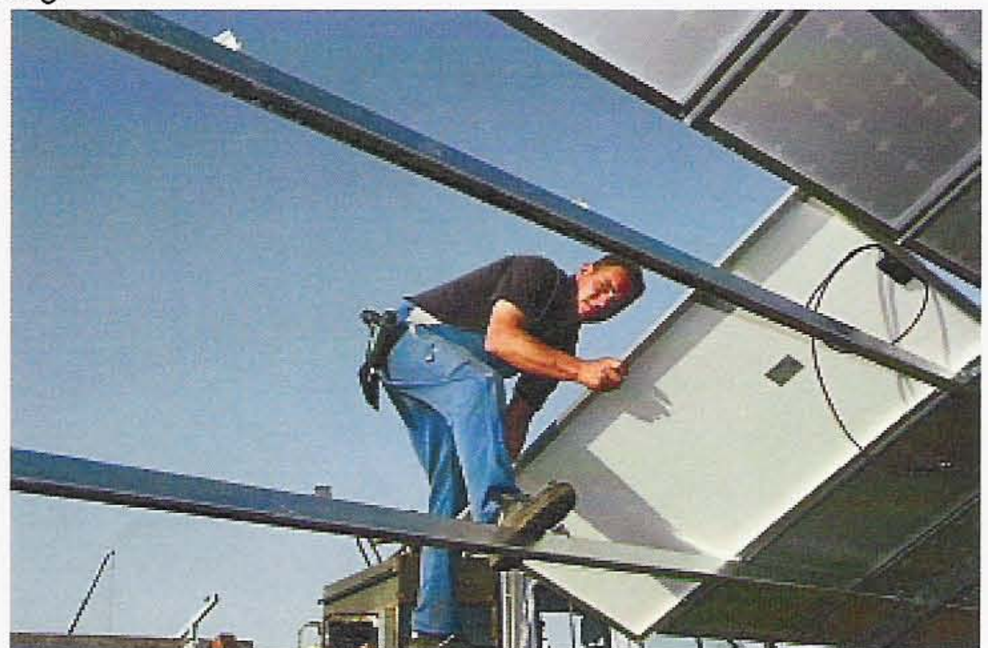
Stück für Stück werden die Photovoltaik-Module installiert. Fotos: Stadt Dülmen/Stefanie Löhn
